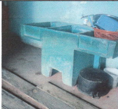
Foto 3: Instalacion de chorros
