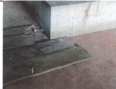
Foto 6: sustitución de piso de torta de concreto
